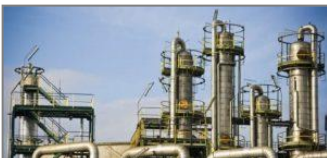
Control y bloqueo de válvulas en refinерías
