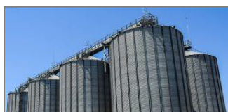
Control del nivel de llenado en silos
