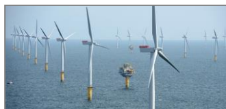
Control de la inclinación de aerogeneradores
