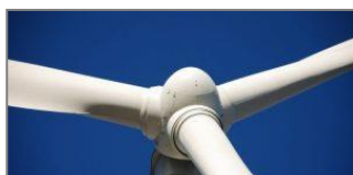
Mantenimiento de aerogeneradores
