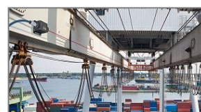
Control de la posición de grúas y elevadores
