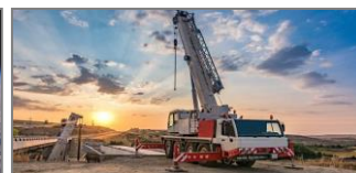
Control de la posición de grúas y elevadores
